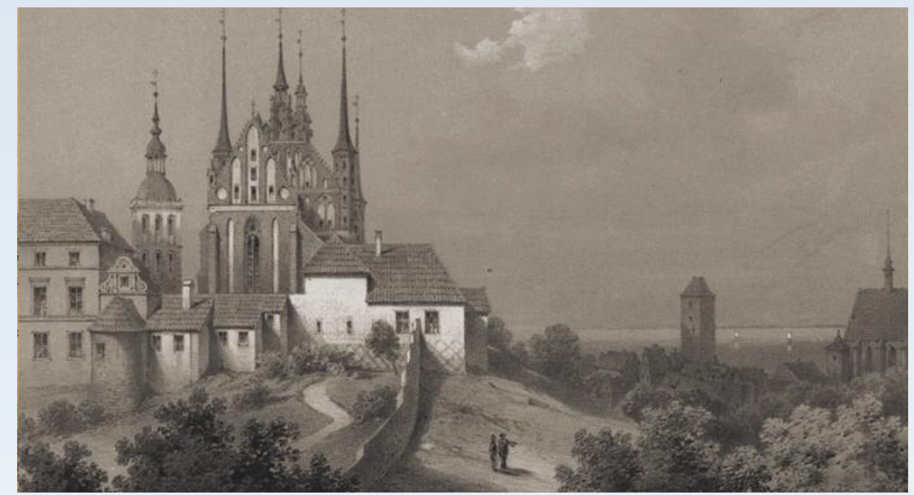
Frombork. Katedra i zabudowa mieszkalna od strony wschodniej
